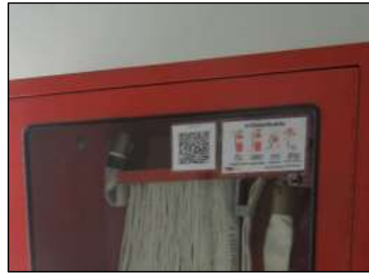
รูปที่ 41 ติดป้ายแนะนำการใช้งาน และตรวจสอบตู้ดับเพลิง และถังดับเพลิง
