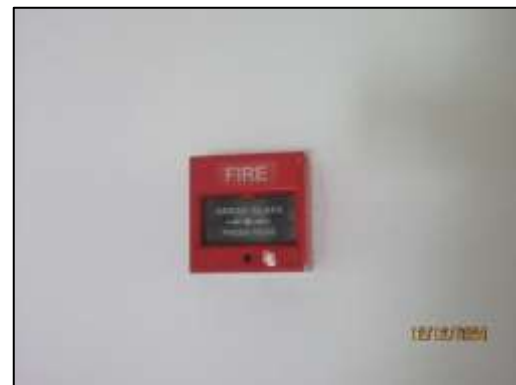
รูปที่ 42 ชุคกดแจ้งเหตุ และกระดิ่งแจ้งสัญญาณเพลิงไหม้
