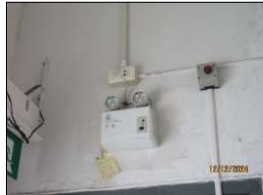
รูปที่ 44 ระบบไฟสำรองฉุกเฉิน
