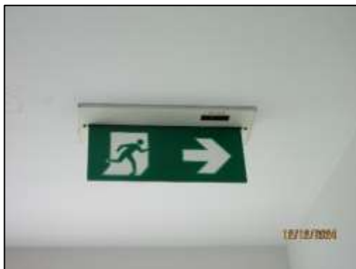
รูปที่ 44 ระบบไฟสำรองฉุกเฉิน
