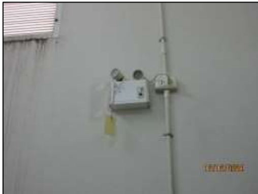
รูปที่ 44 ระบบไฟสำรองฉุกเฉิน
