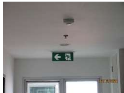
รูปที่ 44 ระบบไฟสำรองฉุกเฉิน
