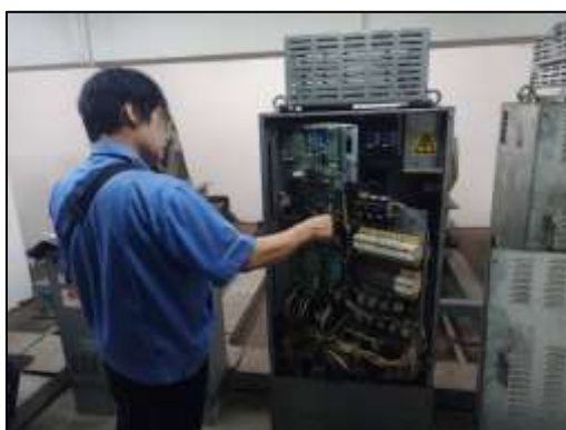
รูปที่ 23 เจ้าหน้าที่ฝ่ายช่างตรวจสอบสายไฟฟ้า สายสัญญาณต่างๆ และอุปกรณ์ควบคุมไฟฟ้า
